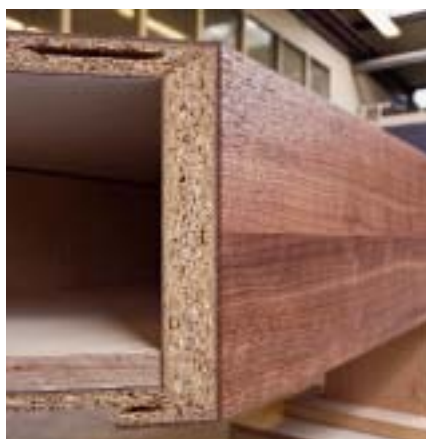
Aufbau der Thekenauflage: Spanplatte und Starkfurnier vom amerikanischen Nussbaum
