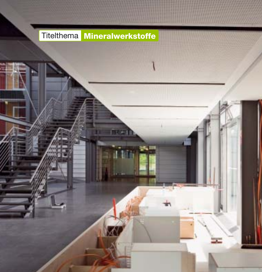
Aufbau des Tresens: Der Mineralwerkstoff wird wie ein Starkfurnier sparsam als Oberflächenveredelung eingesetzt
