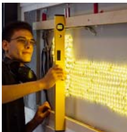
Ausrichten der Nutleistenaufhängung für das Corianpaneel. Ein LED-Schlauch beleuchtet ...
